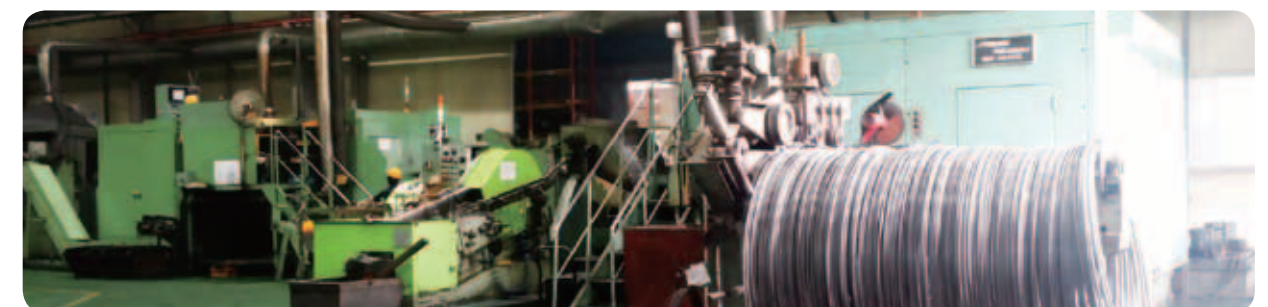
03 열처리 장비 Heat Treatment Facility
